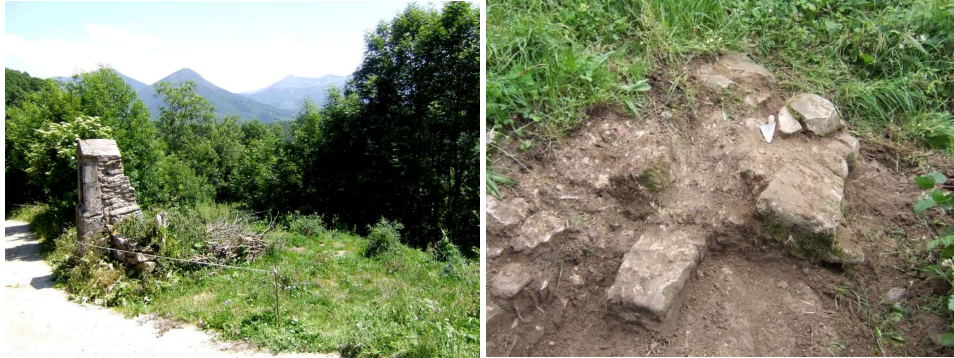
Fig. 4: Humilladero junto al arroyo en el lugar de las Animucas. En este solar debió ubicarse el antiguo templo parroquial anterior al actual. La fisonomía de contrafuerte se interpreta como el único resto en pie de la iglesia vieja.
