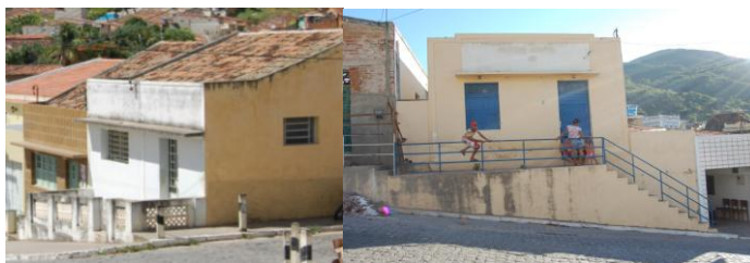
Figs. 18 e 19 - Arquitetura vernácula conforme código local proveniente de meados do século XX (marquise estruturada e esquadrias basculantes). Fonte: acervo Fundarpe/2010
