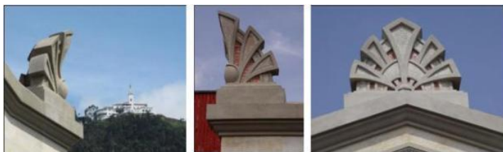
img. 12 Detalles decorativos de la fachada restaurados. 2008.
