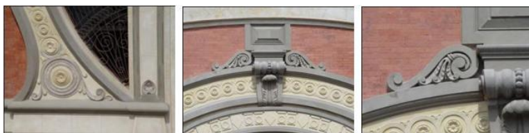
img. 13 Detalles ornamentales en fachada, restaurados fuentes bitácora de obra 2010.
