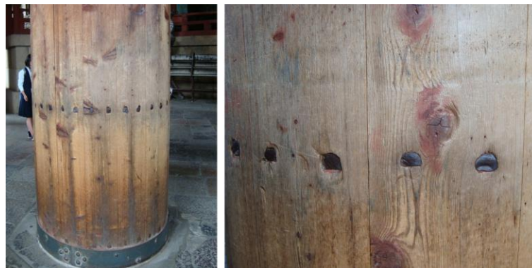
Figura 2 – Detalle del refuerzo estructural del pilar en madera de obtusa (ciprés japonés) Templo Tōdai-ji in Nara (archivo del autor, junio 2013)
