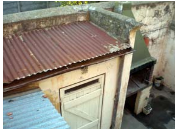
Foto 19.- Vista Baños Exteriores
