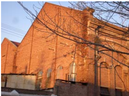
Foto 7.- Usina en calle Brickman
