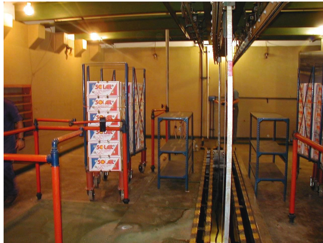
Fotografía 3. El recinto de irradiación en la Planta Semiindustrial del CENTRO ATÓMICO EZEIZA
