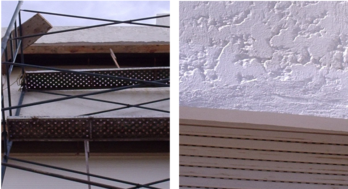
Fotografía 9 y 10. Elementos reparados
