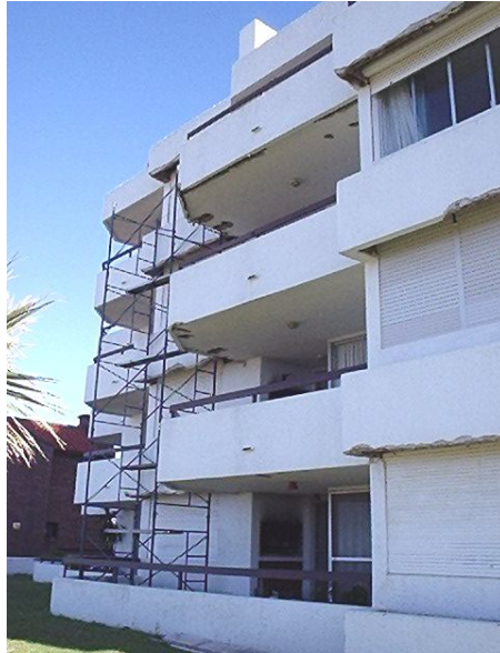
Fotografía 1. Vista general del edificio
