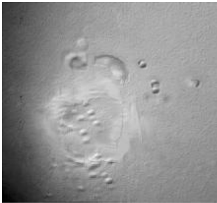
Fotografía 1. Aspecto del piso con aglobamiento superficial
