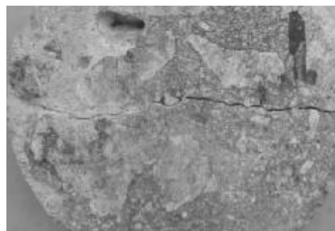
Fotografía 4 Trozos de testigos apoyados en agua una semana. Se observa una fisura diametral y agregados alterados.
