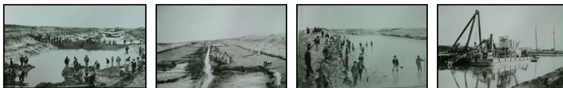
Figura 2: Construcción del Puerto (fotografías de Tomas Bradley 2 en Rivelli, 2007)
