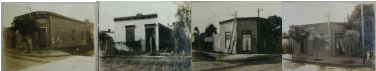
Figura 13: Fachadas manzana 50, parcelas 14 (1911); 2 (1911); manzana 54, parcelas 1 (1940); 15 (1911). Dirección de Obra Particulares, Municipalidad de Berisso.
