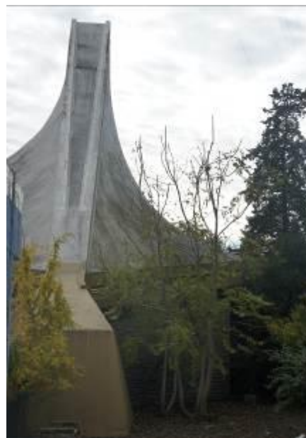
Figura nº 22: Lucernario desde exterior.
