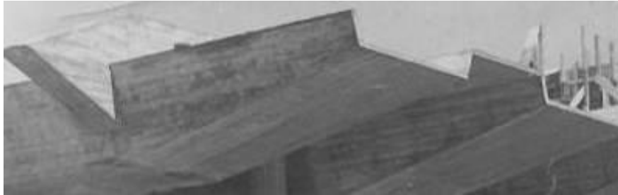
Figura nº 13: Losa: lámina plegada de hormigón armado a la vista, espesor 8 cm.
