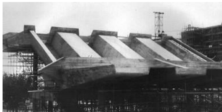
Figura n° 16: Hormigón a la vista.
