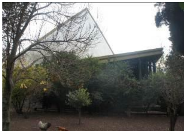
Figura n° 19: Vista hacia el contrafrente
