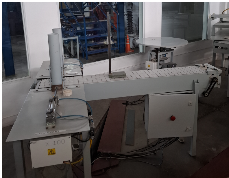
Figura 5.5: Celda de manufactura. Vista principal de cinta transportadora y mesa giratoria.
