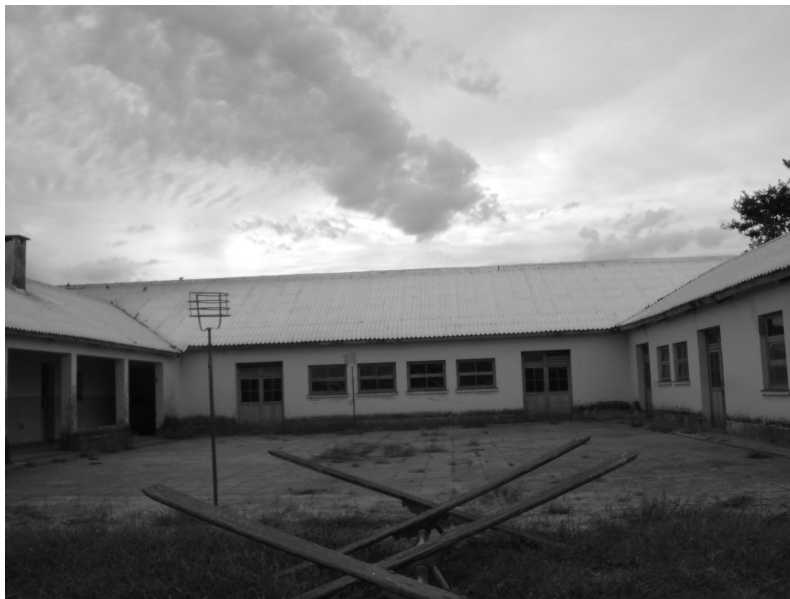
Escuela Provincial N° 6282 Ubicación: área rural, Cuatro Esquinas
