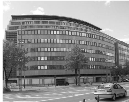
Figura 6. Arquitectura Moderna, Alemania.
