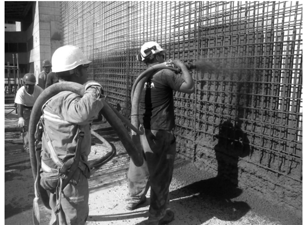
Figura 3. Operario proyectando hormigón en tabique.
