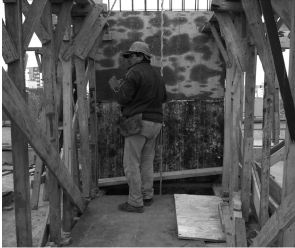
Figura 2. Elevación de materiales (hueco de ascensor) sobre estructura inestable.
