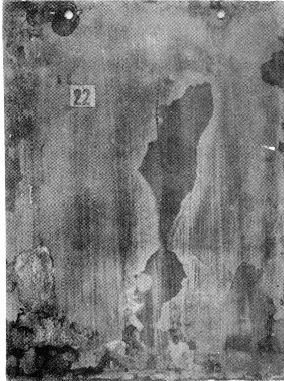
Fig. 4.- Ataque del panel metálico como consecuencia de la fijación de fouling, afectando la continuidad de la película; pintura AF-4, 36 meses de inmersión
