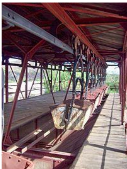
Vista Estación N° 1 Vagonetas y cinta transportadora.
