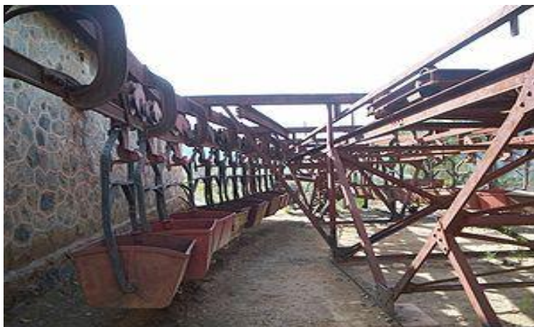
Estación del Cable Carril
