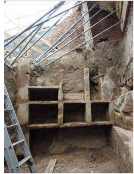
Fig. 8 Estanterías posteriores a su construcción
