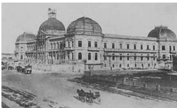
Palacio de Justicia durante su construcción en 1884.
