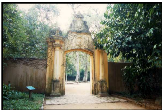
Figura 2 – Portal da Fábrica de Pólvora – 1997
