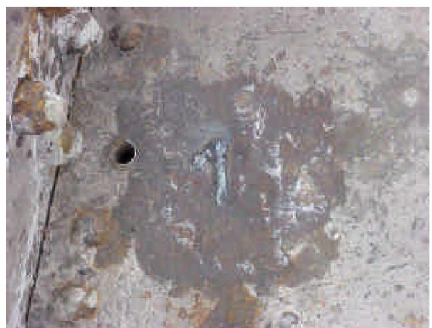
Foto Nro. 17 Sistema de numeración por medio de soldadura de arco eléctrico
