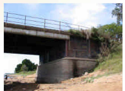
Foto Nro.9 Vista del Estribo lado Castelli realizada con mampostería de fábrica en una etapa posterior.
