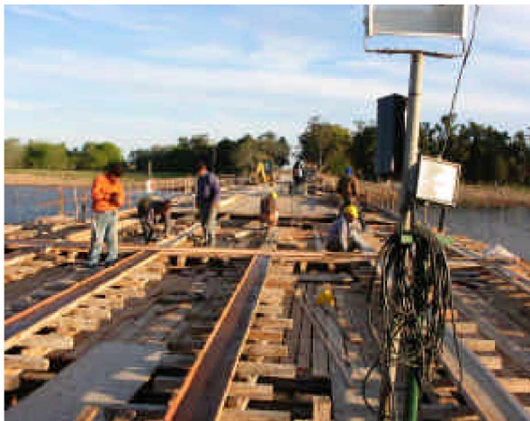
Foto Nro. 14 Estructura de refuerzo para soportar la carga del nuevo puente
