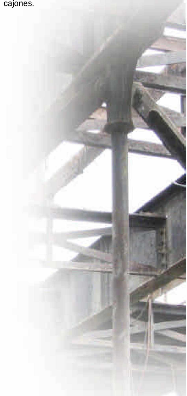
Foto Nro.6 Estructura Modular del puente
