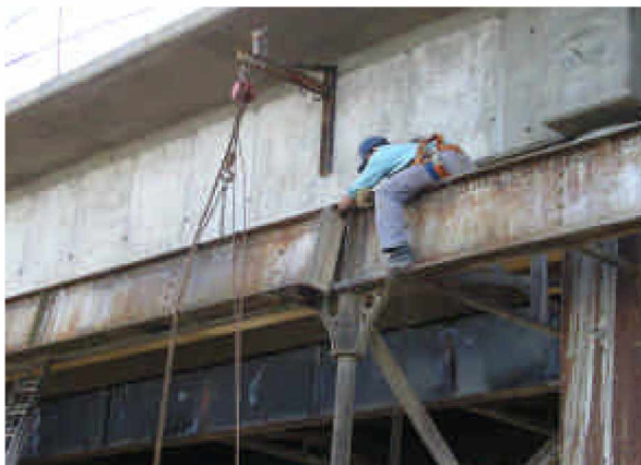
Foto Nro. 20 métodos de desarme de las vigas longitudinales utilizando de estructura de soporte el puente de hormigón
