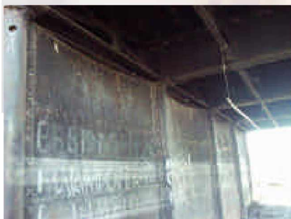
Foto Nro.7 Vista inferior del Estribo del Lado de Lezama
