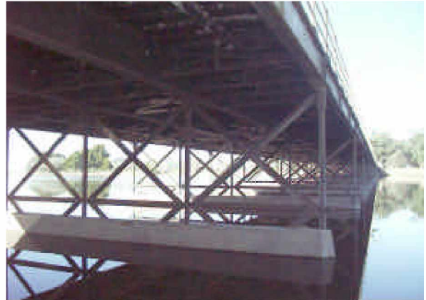
Foto Nro. 3 donde se muestra la estructura modular del Puente
