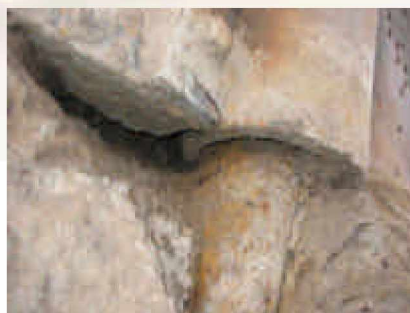
Foto Nro.8 Sistema de Fundación del estribo
