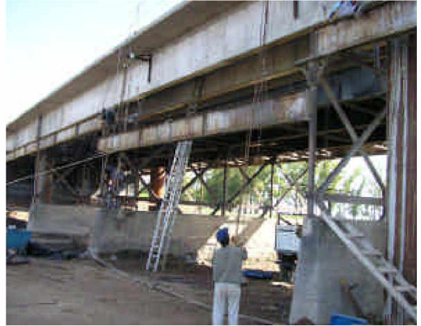
Foto Nro. 21 Método de desarme de las planchas de piso de hierro batido
