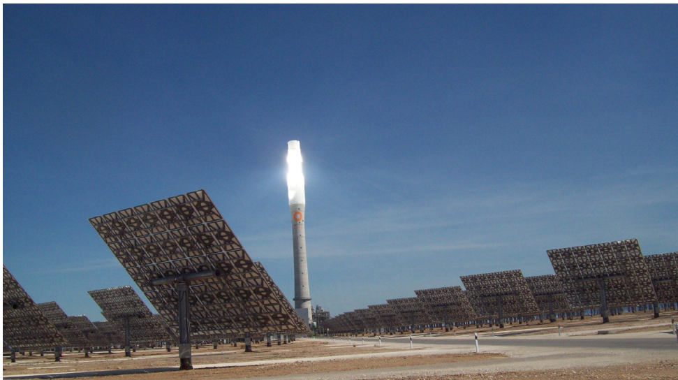
Figura 2. Torre solar Gemasolar Sevilla 20 MW
