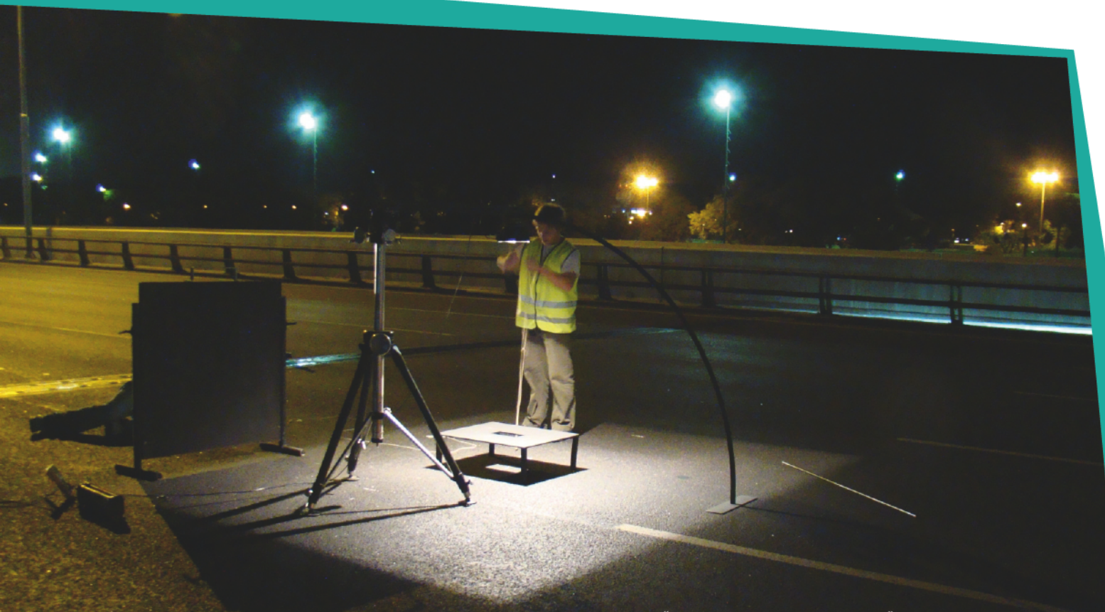
En pleno trabajos sobre la calzada de la Autopista Illia: mediante el “Reflectómetro de calzadas”, el equipo del LAL observa cómo el pavimento refleja la luz que emiten las luminarias
