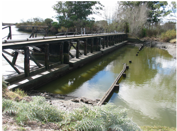
Foto N° 3: Vista aguas abajo, se observa el marco de las compuertas Stop Lanks, restos de pilotes y viga transversal de cierre del blanquet de aguas abajo sobre el arroyo El Palenque.
