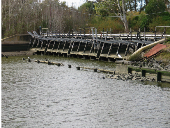
Foto N° 7: Vista de los estribos de fábrica revocados y los taludes con protecciones de pie.
