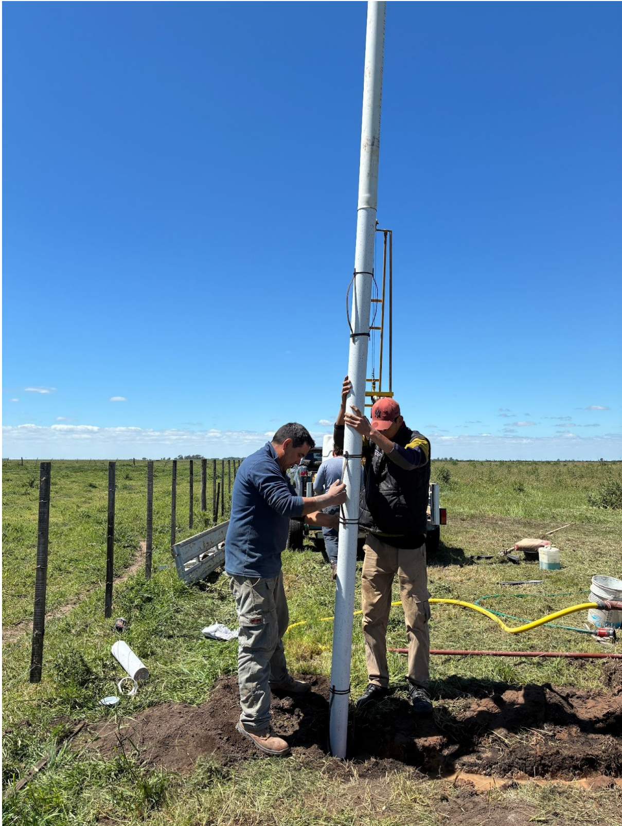
Figura 4: Instalación de cañería de pvc perforado con sus centradores.
