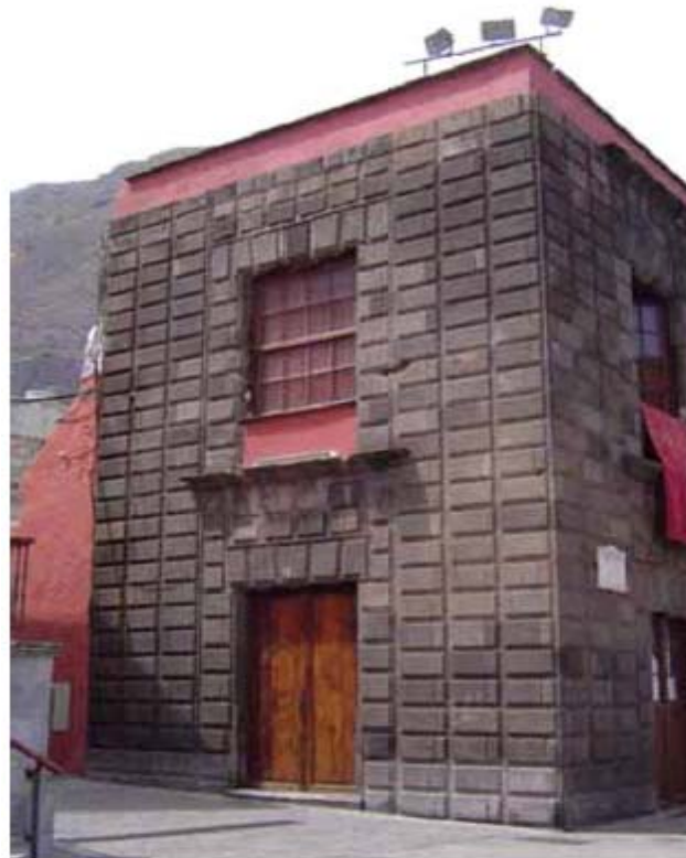
FACHADA LATERAL IZQUIERDA.
