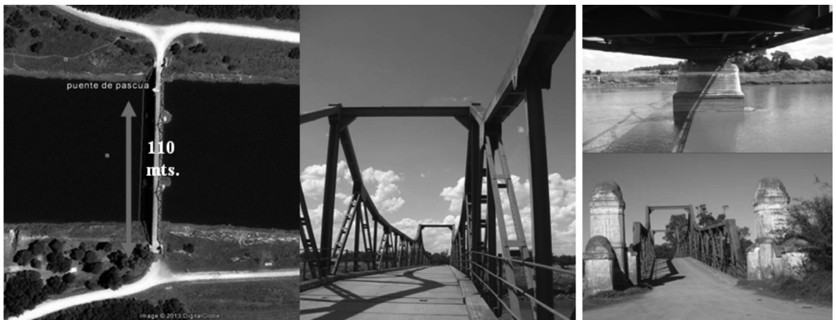
Figura 15. Fotos actuales del puente. Fuente: Fotos del autor.
