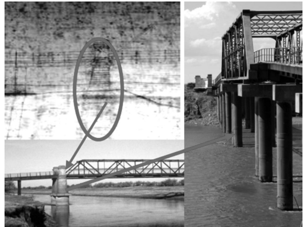
Figura 23. Puente de Uranga (antes del reemplazo de las fundaciones) y fotos actuales. Fuente: Archivo y Museo de Castelli (1980). Fotos actuales del autor (2013).
