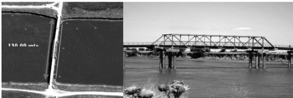
Figura 25. Canal y puente en estado actual.
