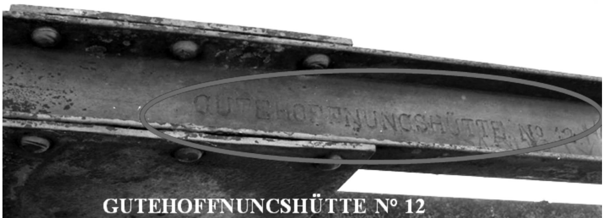
Figura 26. Perfil de hierro con inscripción gravada en el hierro. Fuente: Fotos del autor.
