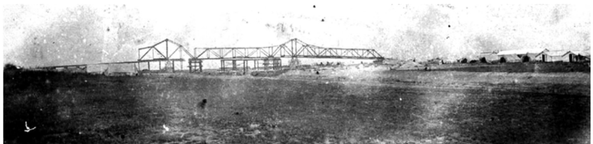
Figura 12. Puente Km 331,00 en construcción (1910). Fuente: fotos Sr. M. Céspedes.
