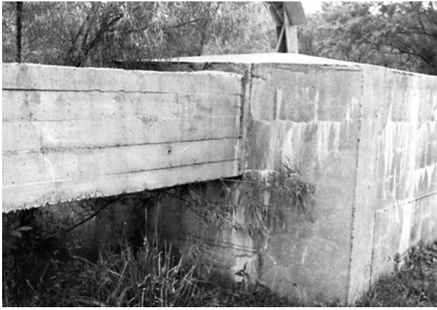
Imagen 1: Base torre de alta tensión. Salto Grande, Entre Ríos. 1987
