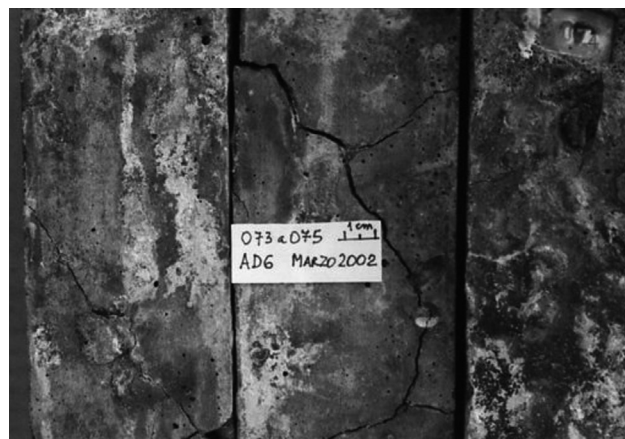
Imagen 6: Probetas de hormigón. Método Iram 1700, con agregado reactivo
