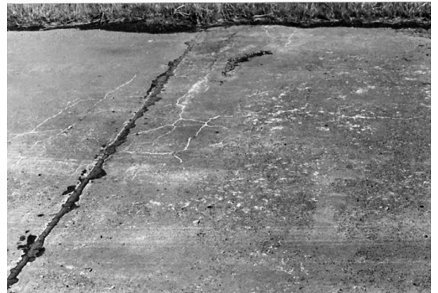
Imagen 12: Pavimento de la pista de aterrizaje, Aeropuerto de Corrientes. 1993
