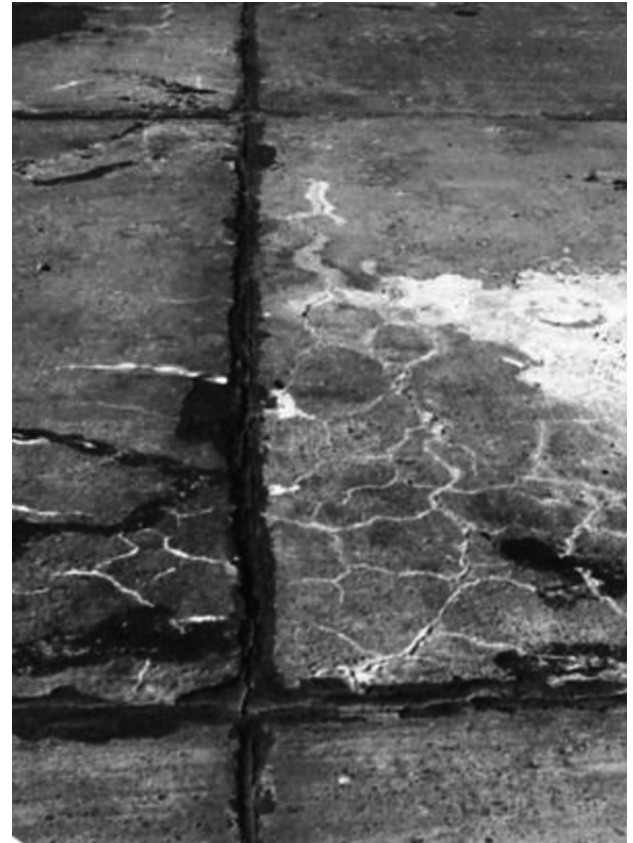
Imagen 10: Pavimento de la pista de aterrizaje, Aeropuerto de Corrientes. 1985
