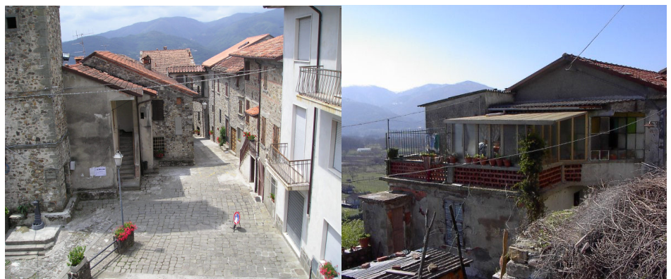
Figura 8 - Elementos de contaminación visual: cables aéreos en las fachadas, intervenciones incongruentes, sobreposiciones.
