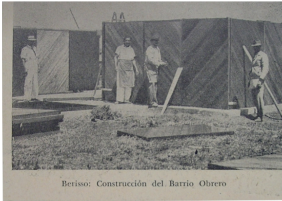
Figuras 8 y 9: (1) montaje de encofrados de madera, (2) desmontaje de encofrados de madera donde se observa la envolvente de la vivienda realizada con tabiques murarios de hormigón y a poca distancia “las vías decauville”, para el traslado de materiales e insumos con “zorras” [7].
