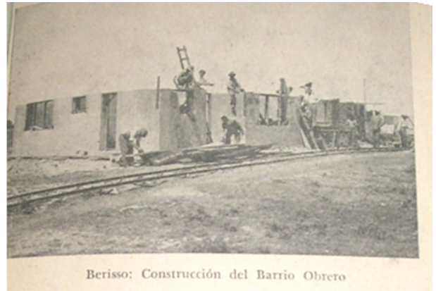
Figuras 8 y 9: (1) montaje de encofrados de madera, (2) desmontaje de encofrados de madera donde se observa la envolvente de la vivienda realizada con tabiques murarios de hormigón y a poca distancia “las vías decauville”, para el traslado de materiales e insumos con “zorras” [7].
