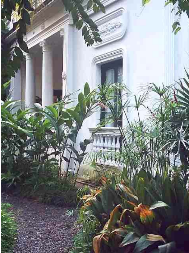
Foto2 – Fachada, vista desde los jardines
