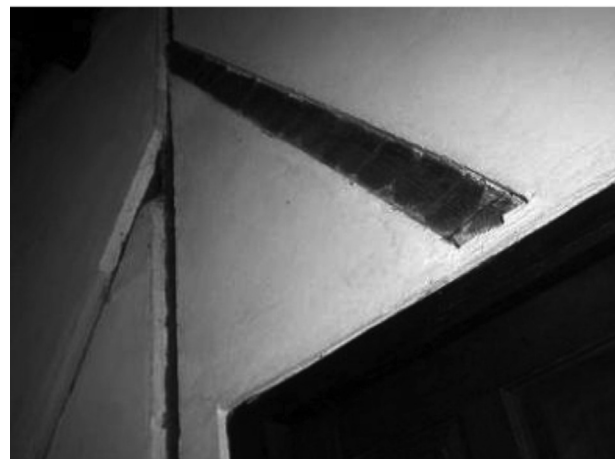
Figura 44: Estructura Casa Toribio (Montevideo)
