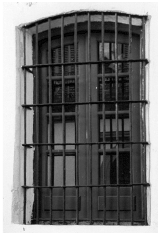
Figura 38: Ventana a vidrio partido, tipología de ventana de múltiples paños con vidrio pequeño. Casa llamada de Liniers.
