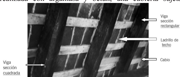
Figura 45: Estructura de los techos, vista interior
