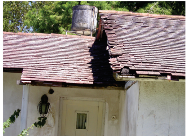
Figura 11: Techo original de tejas (fotografía enero 2007, vivienda ubicada sobre calle 172, Mz. 40a, parcela 11)
