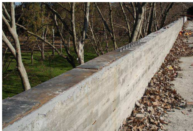
Figura 12: Viga de hormigón armado reforzada con planchuelas metálicas
