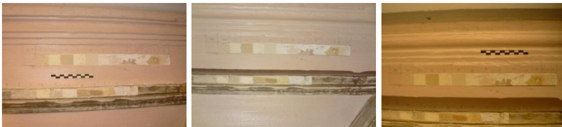
Figura 2: Antesala. Ejecución de cateos en ornatos y muros.
