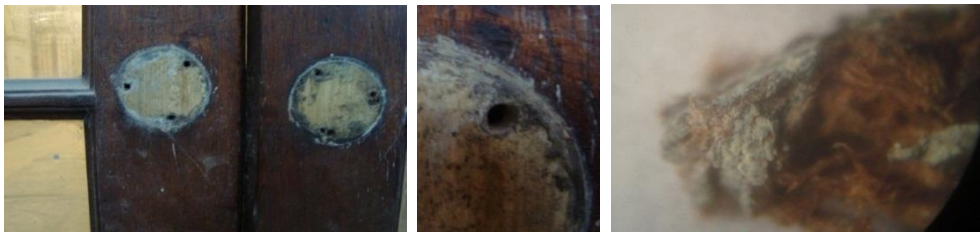
Figura 14: Carpintería exterior, Portón de acceso a Foyer principal. Microfotografía. Vista superficial de la capa pictórica en contacto con la madera 40X.
