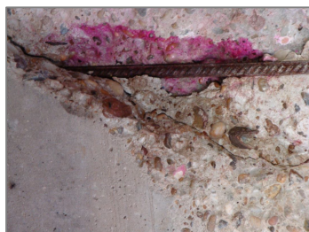
Fig. 14 Ensayos de carbonatación en las vigas de borde sobre los estribos.
