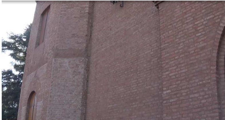
Figura 6: Estado de fachada en 2014
