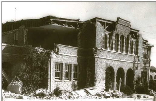
Figura 1: A. Hamilton Jr High School, 1933 Terremoto de Long Beach, Estados Unidos
