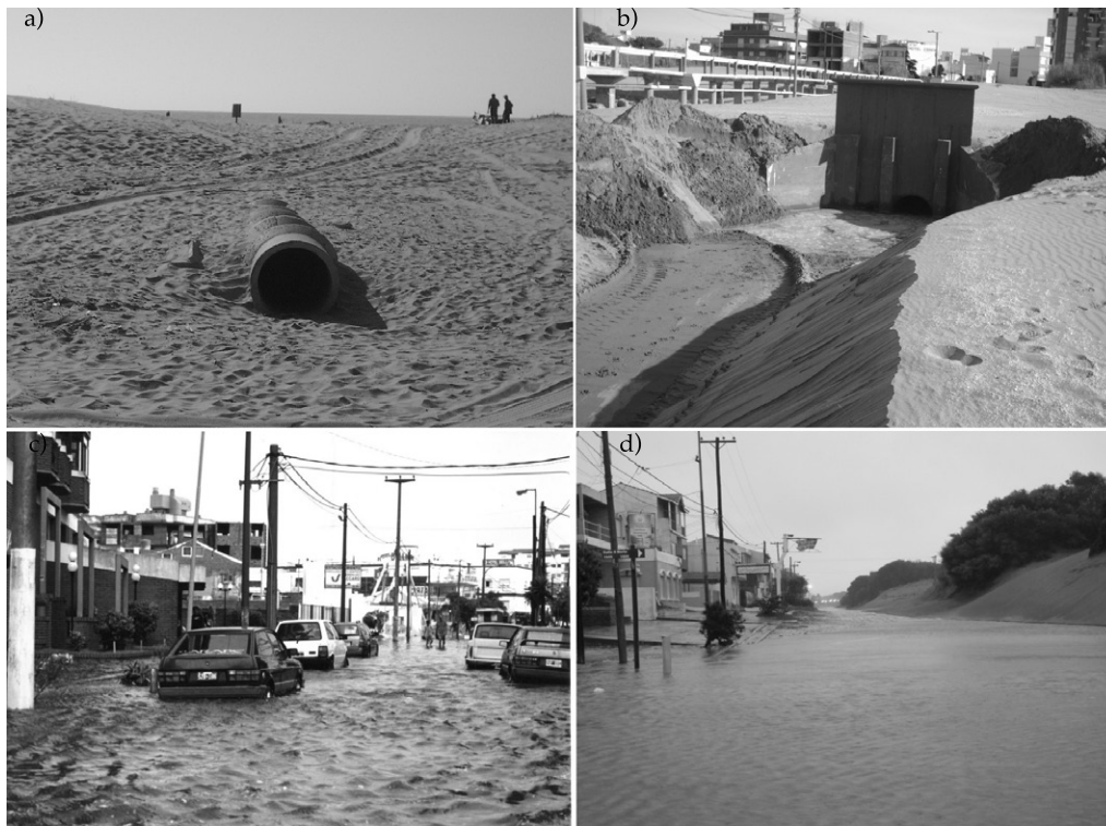
Figura 8. a) Caños pluviales colocados en la Av. Costanera, que descargan hacia la playa y el mar; b) desagüe que termina en la playa, donde posteriormente el flujo se conduce al mar; c) calles inundadas en la costanera de San Clemente del Tuyú.
