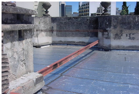
Trabajos de consolidación en terraza
