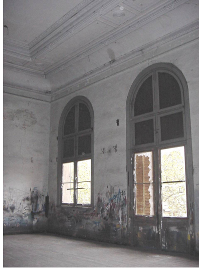
Estado previo a la restauración
