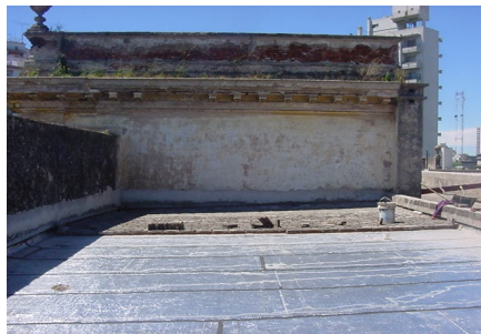
Impermeabilización en la cubierta
