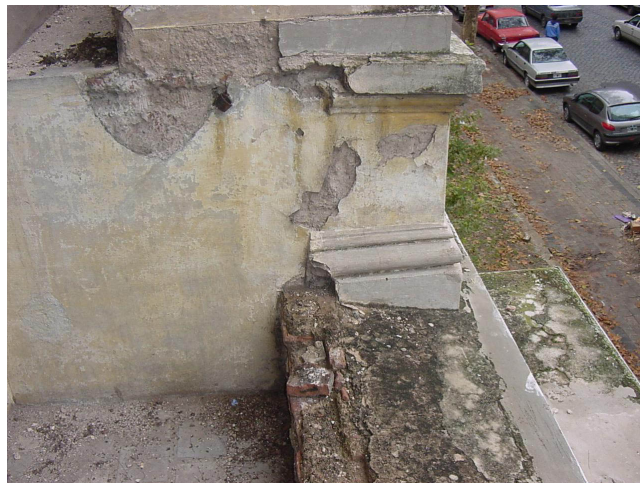
Estado previo a la restauración
