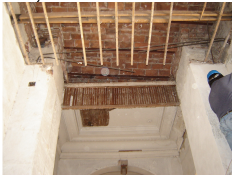
Estado previo de cielorrasos
