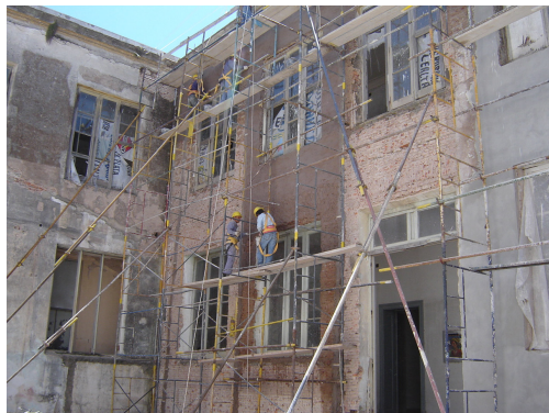
Durante la ejecución de los trabajos
