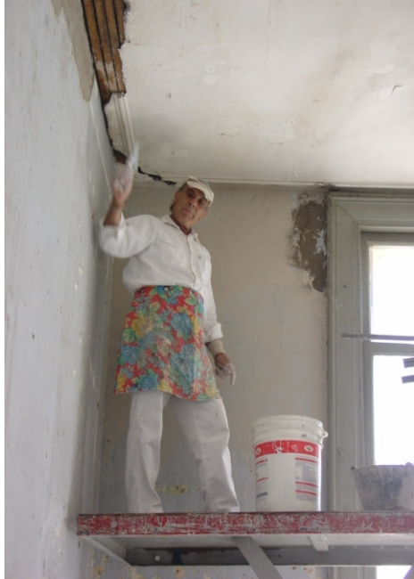
Trabajos de restauración de cielorrasos
