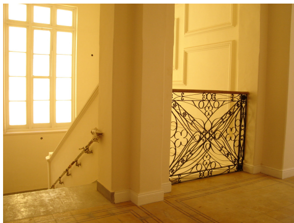
Acceso a escalera
