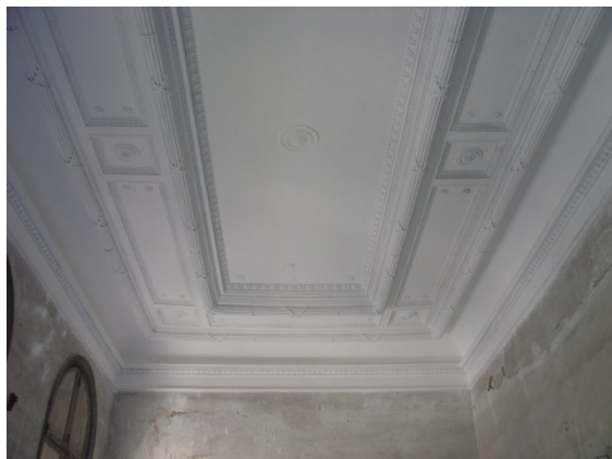
Cielorraso del salón principal
