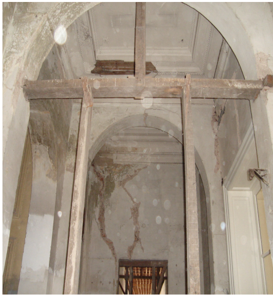
Muro divisorio en planta alta
