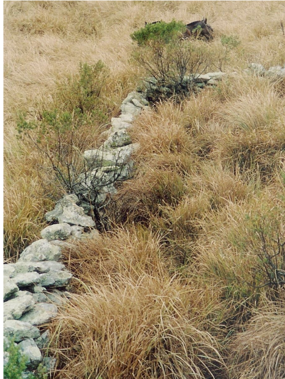
Figura 8. Muro de pirca simple afectado por el crecimiento de pastizales y arbustos en las Sierras del Azul.
