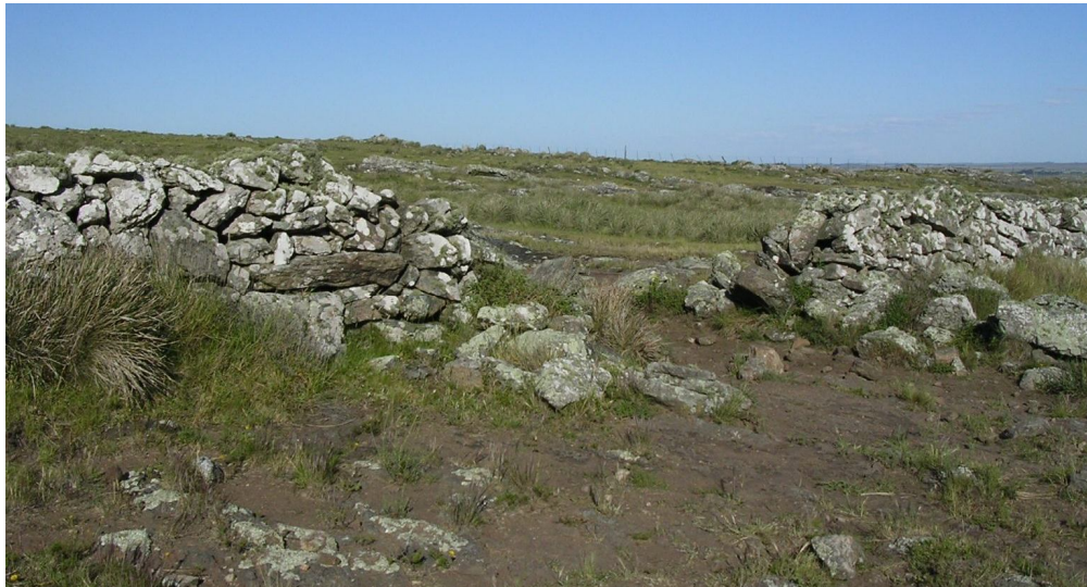
Figura 6. Tramo del Muro Nro. 3 que se encuentra derruido (Sierras del Azul).
