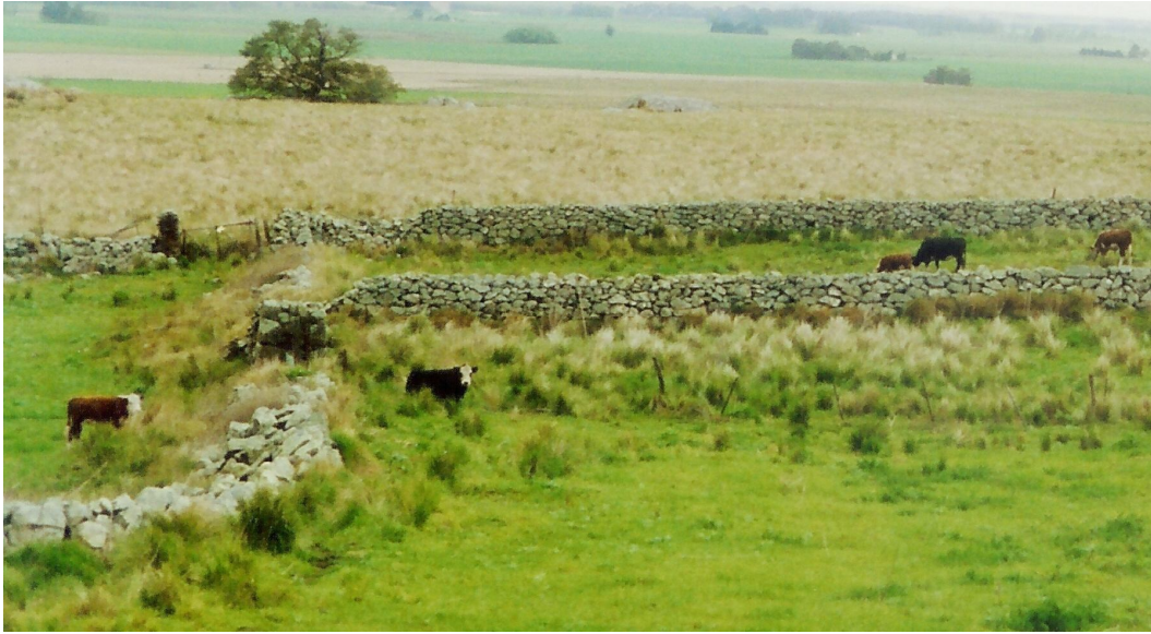
Figura 5. Ganado vacuno en el interior de las estructuras A y B de la construcción situada en estancia Millá Curá. Se notan varios tramos del muro parcialmente derrumbados, así como el agregado de una tranquera
