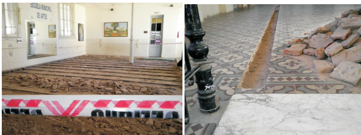
Figuras 11 y 12: piso de la planta alta removido. Fuente: Catálogo de bienes patrimoniales de Bragado.
