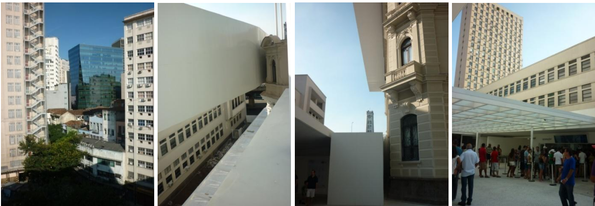
Figuras 7 – 8 – 9 - 10: Vista a partir da cobertura / Passarela suspensa/ Passarela e rampa de saída/Marquise com bilheteria
