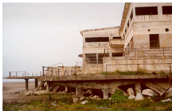
Figura 17: Vista del edificio Normandie año 2002.
