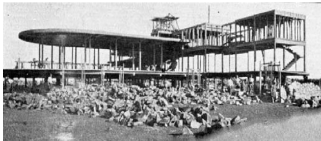
Figura 22. Vista del edificio Jockey club durante su construcción.
