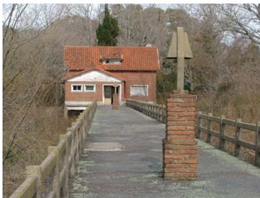
Figura 23: Vista del muelle de pesca. Se observa una columna de iluminación ejecutada en hormigón armado.
