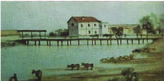
Figura 31: Puente de Barracas, 1841, construido en madera
