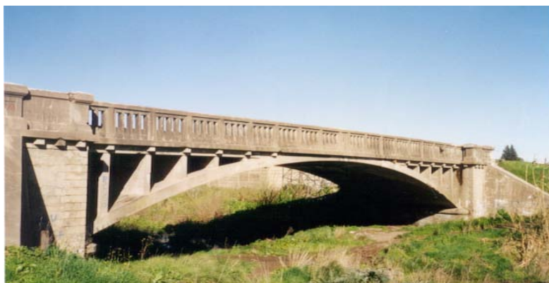
Figura 34 – Primer Puente arco de Hormigón armado, construido en Argentina en 1916, diseño del Ing. Donato Gerardi
