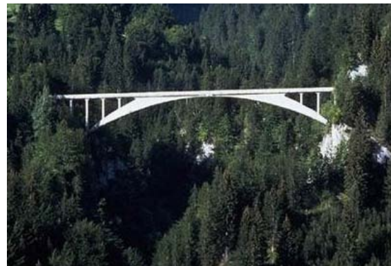
Figura 29: Puente Salginatobel, Suiza.
