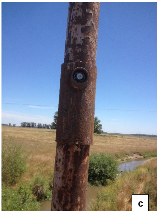
Figura 3. Características de la torre e instalación. a) Torre instalada. b) Anchaje sobre el puente. c) Tapa de inspección con bolón de seguridad. d) Agujeros para ingreso del agua en la cámara
