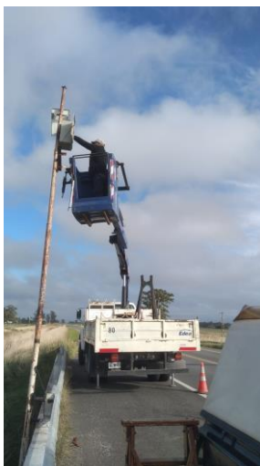
Figura 10. Cambio de batería.
