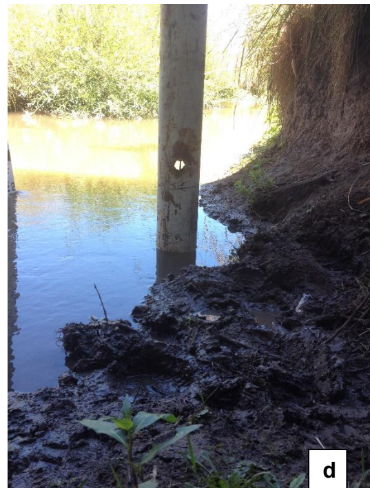
Figura 3. Características de la torre e instalación. a) Torre instalada. b) Anchaje sobre el puente. c) Tapa de inspección con bolón de seguridad. d) Agujeros para ingreso del agua en la cámara
