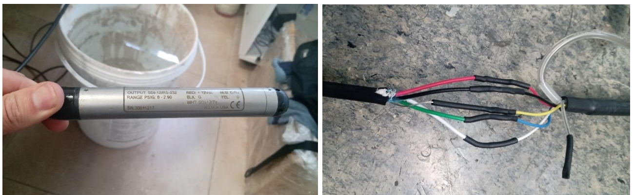
Figura 5. Sensor utilizado y el empalme de los cables.
