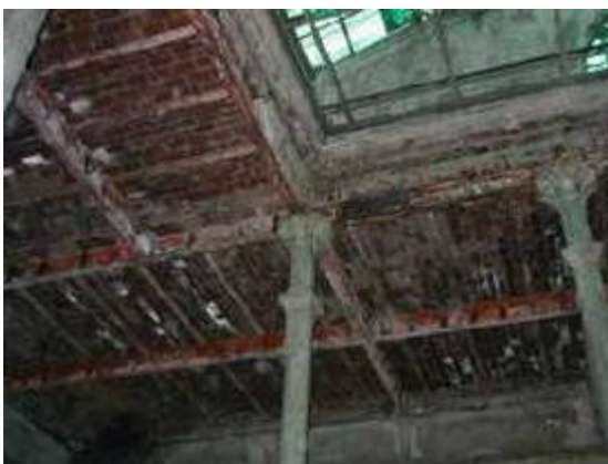
Fig. 16 – Columnas H. F. en P. Principal
