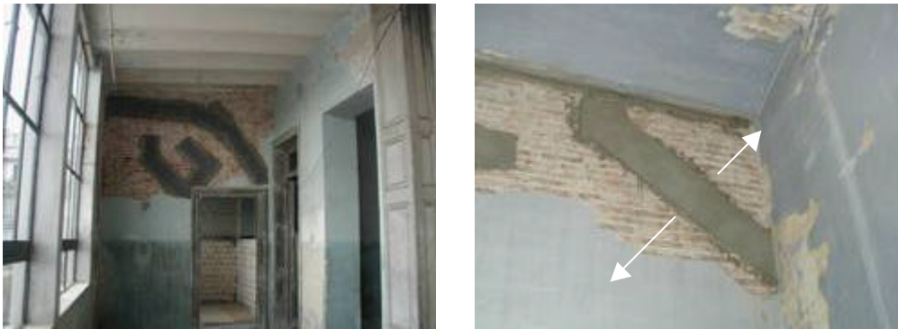
Fig. 51 y 52 – Refuerzo de muros transversales
