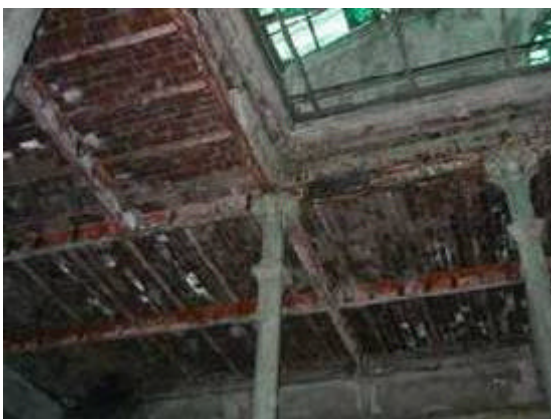
Fig. 16 – Columnas H. F. en P. Principal
