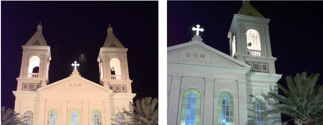
Fotografía 4. Iluminación Fachada Principal
