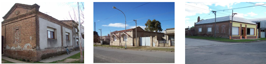
Figura 19. Degradación de viviendas de primera generación
