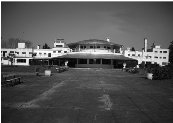
Imagen 8: Vista actual desde el río.
