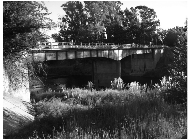
Imagen 3: Puente de Hormigón armado, año 1960. Sauce Grande. Ruta Nacional N° 3.
