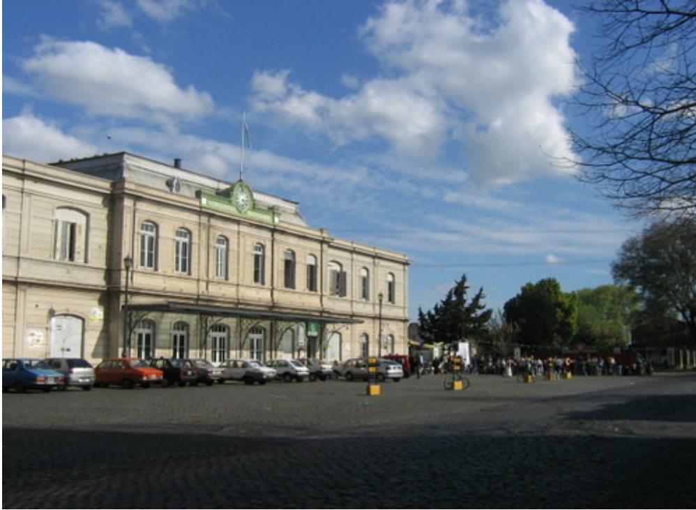
Aspecto actual de la ex estación ferroviaria. El edificio original fue ampliado con el agregado de un piso en las alas laterales al cuerpo central a la vez que despojado del coronamiento de mansarda.
