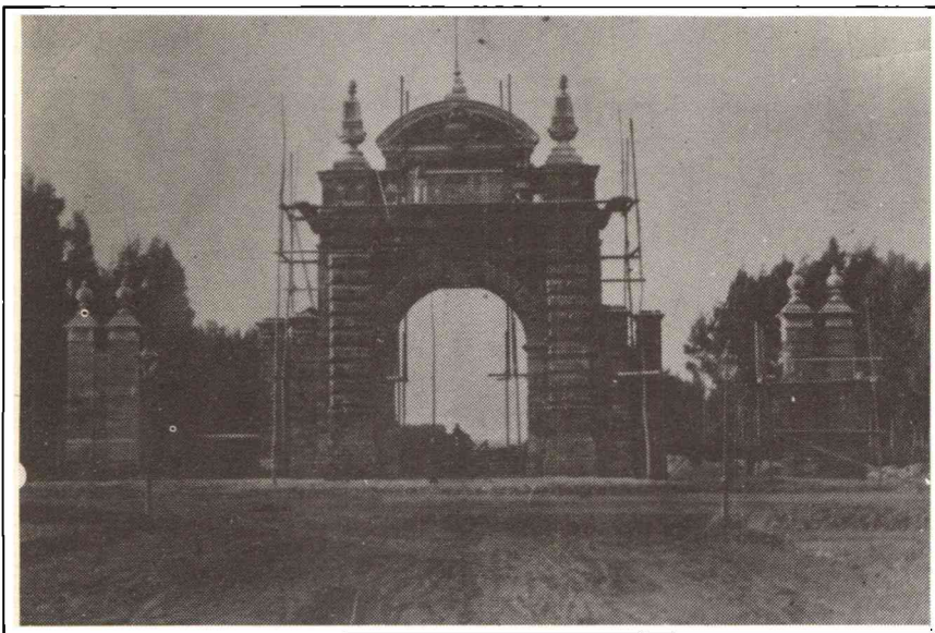
Foto 2 Arco de ingreso (en construcción)
