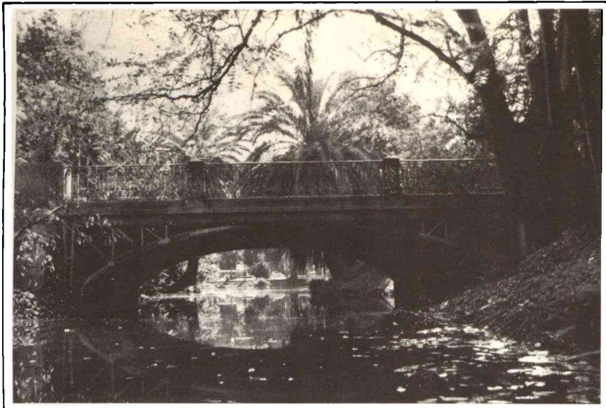
Foto 3 Puente de acceso a la isla del Lago
