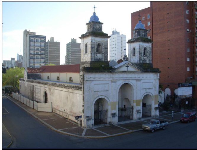
Fotografía 16- Perspectiva tomada desde Tribunales. Se advierten pruebas de color en su fachada principal.
