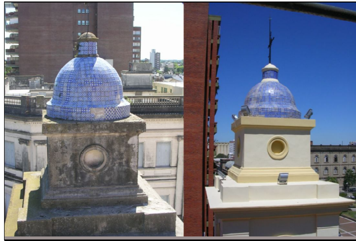
Fotografía 15- Perspectiva de un cupulín antes y después de la intervención, con reintegración de piezas e incorporación de valores cromáticos.
