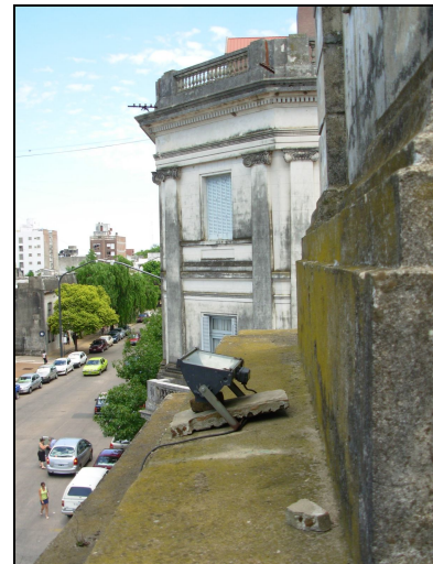
Fotografía 20- Parte superior de la cornisa en la que se advierte ataque biótico.
