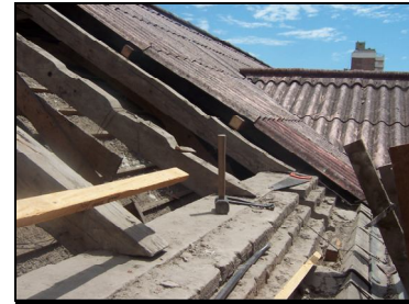
Fotografía 5- Apoyo de tijeras en muro lateral.
