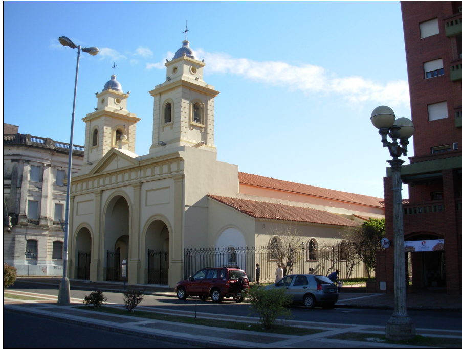
Fotografía 9- Imagen final con la reposición del techo de tejas coloniales sobre nave principal.
